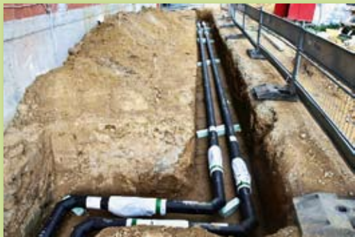
Bauarbeiten von Wärmeleitungen.
